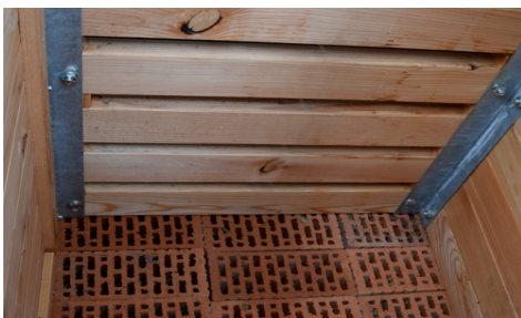
durchlässige Mittelwand und Lochziegelboden
